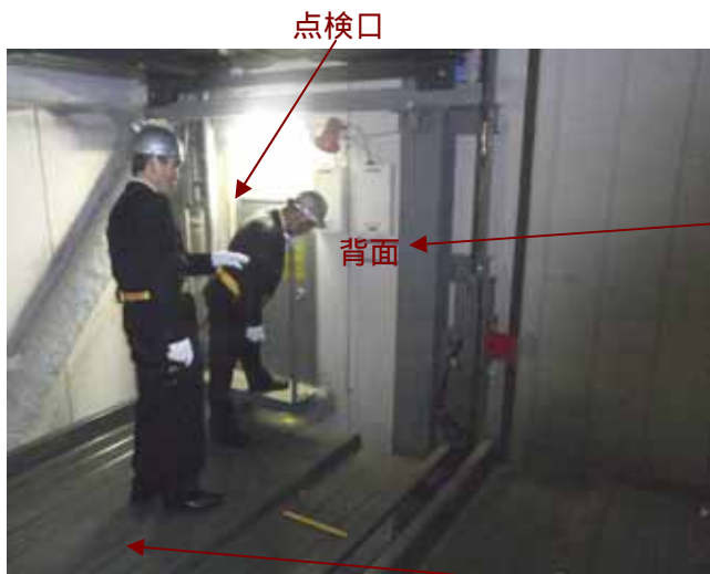
写真3 パレットと点検口及びタラップの設置状況
