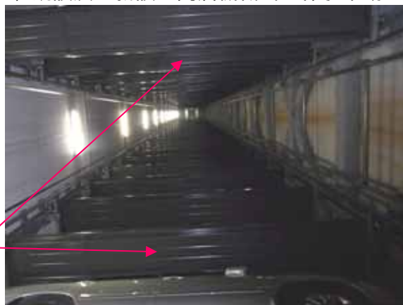
写真1 高層機械式立体駐車場の内部を昇降装置の位置から上部を写す。両脇はパレット。
