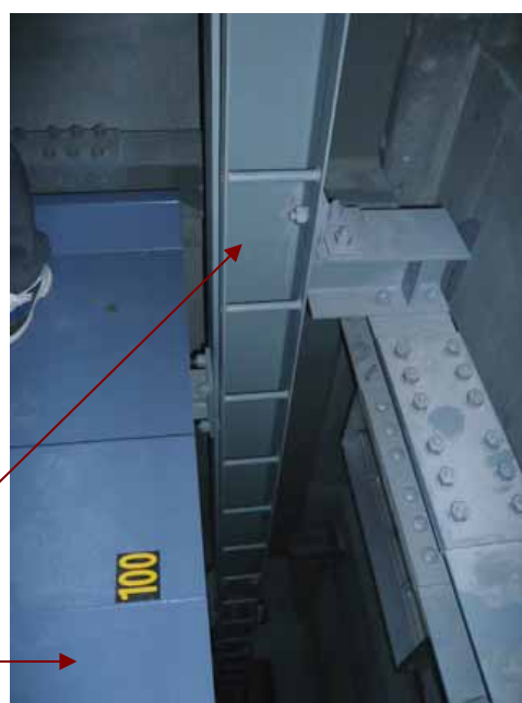
写真8 トラップの状況 ステップからトラップの下方を写す。
