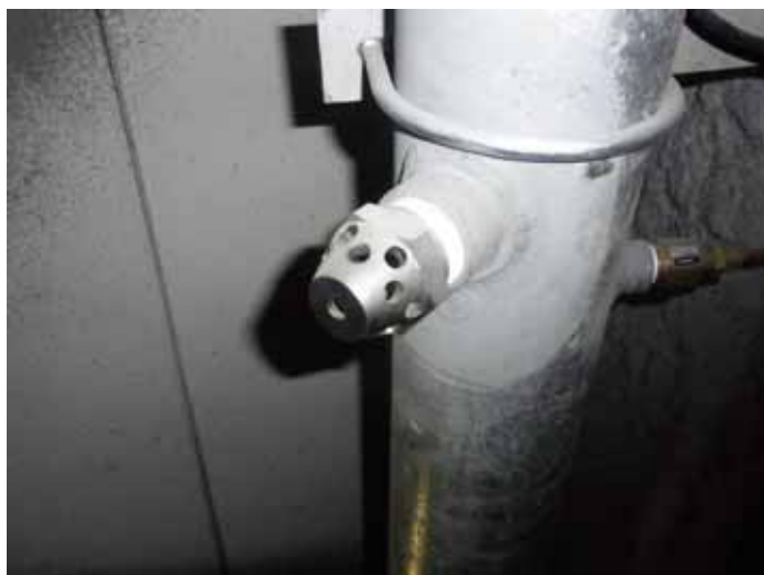
写真9 噴射ヘッドの設置状況
