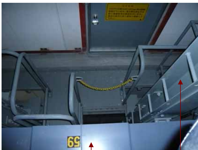
写真7 点検口、トラップ、ステップの状況
